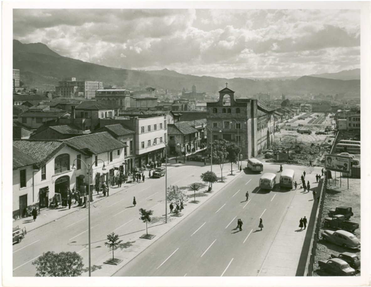
Imagen 1. Iglesia del barrio Santa Inés, demolida durante la construcción de la Carrera Décima
