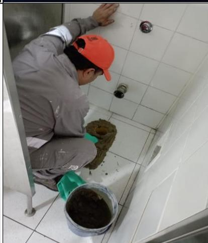
Se muestra el taponamiento constante a los aparatos sanitarios por disposición inadecuada de toda clase de elementos y/o mal uso dejándolos fuera de servicios, situación que se está atendiendo por el personal operativo de mantenimiento Idipron en la semana entre el 07 y 16 de octubre de 2024, como se puede apreciar en el registro fotográfico
