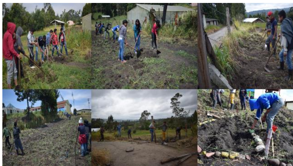
Figura 2. Registro fotográfico de la adecuación del terreno.
